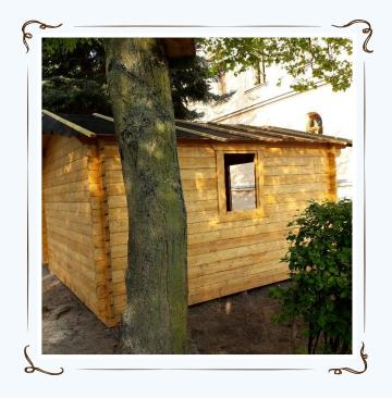
Nach nur 3 Tagen Bauzeit steht das Lesehaus in voller Größe auf dem Schulhof und integriert sich wunderbar in das Schulgelände. Die Bauarbeiten sind noch nicht abgeschlossen. Das Dach muss noch wetterfest, die Türen und Fenster eingesetzt und die Inneneinrichtung geplant werden.
